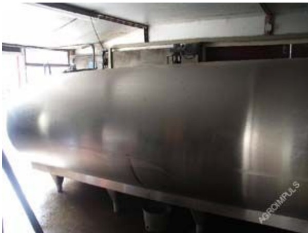
Milchtank, Fassungsvermögen 8200 Liter
